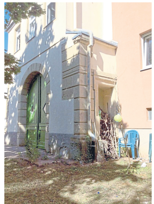
Die rechte Risalitecke mit der zugemauerten Seitentür, 2019.
