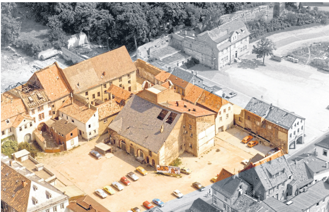
Der Schlossbereich während der Abrissarbeiten 1978 farbig markiert.
