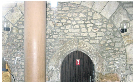
Mit Bruchsteinen vermauerte Verbindung zum früheren Kirchenschiff.
