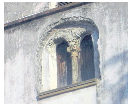
Zustand vor der Renovierung.
